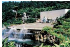
杉乃井地熱発電所 Suginoi 出力 Output 3,000kW
