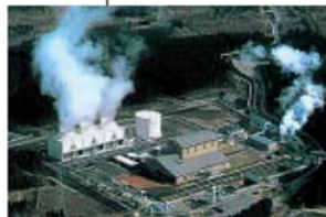
滝上地熱発電所 Takigami 出力 Output 25,000kW
