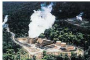
澁川地熱発電所 Sumikawa 出力 Output 50,000kW
