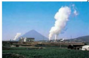
山川地熱発電所 Yamagawa 出力 Output 30,000kW
