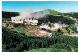
八丁原地熱発電所 1・2号 Hatchobaru No.1, No.2 出力 Output 55,000kW, 55,000kW
