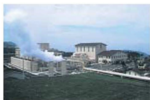
大嶺地熱発電所 Ogin 出力 Output 30,000kW
