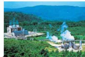
大沼地熱発電所 Onuma 出力 Output 9,500kW
